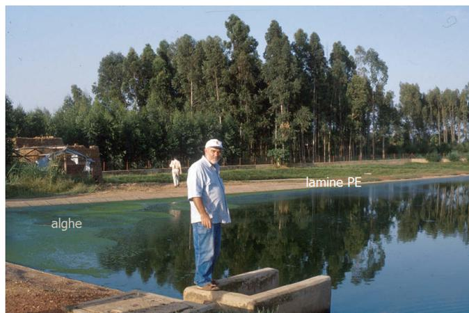
Nell'acqua in ingresso c'è un carico di colibatteri dell'ordine di 120 milioni circa per 100 ml, all'uscita il carico è di 5000 per 100 ml. Per le acque in uscita
